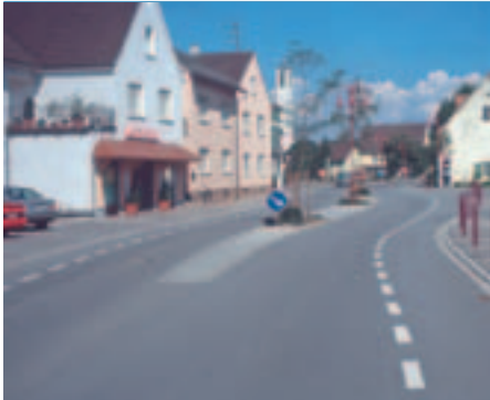
Schutzstreifen in einer ländlichen Ortsdurchfahrt
