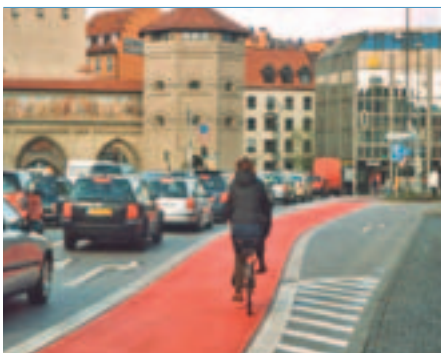
Direkt geführte Radverkehrsfurt an einem hoch belasteten Knotenpunkt
