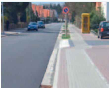
Rad- und Gehwegüberfahrt der Einmündung einer Nebenstraße
