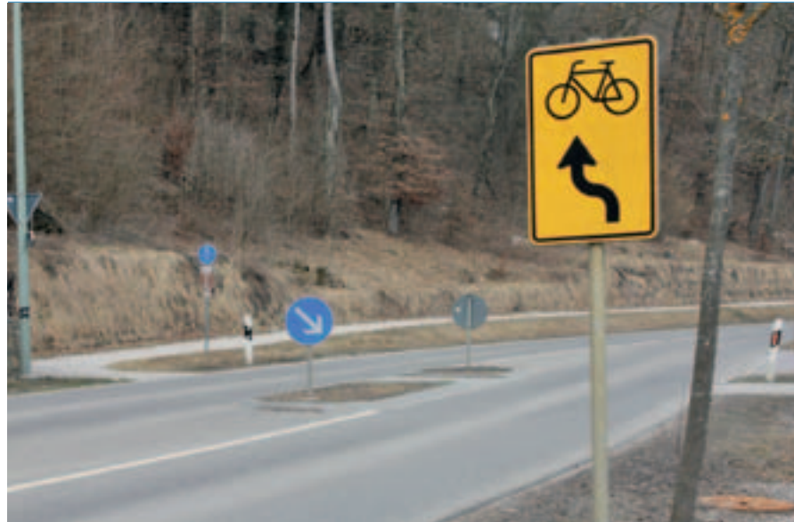
Querungshilfe am Ortsrand
