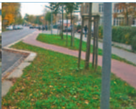
Heranführen eines Radweges vor einem Knotenpunkt
