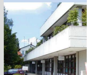
Außenstelle Eichthalstraße „Post“
