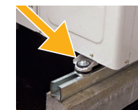
Gummipuffer helfen, den Körperschall zu reduzieren.
