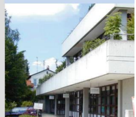
Außenstelle Eichthalstraße „Post“
